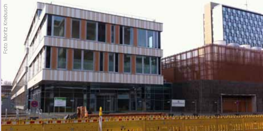
Zurzeit eine Baustelle: Das Partikeltherapiezentrum am UKSH
